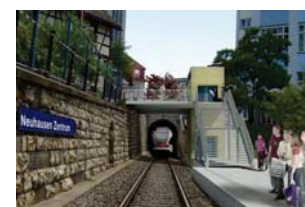
neue Haltestelle als Erschliessung des Entwicklungsschwerpunktes SIG-Areal
