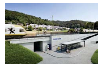
Unterführung zum Entwicklungsschwerpunkt Wohnen in Beringen
